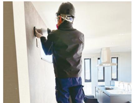
粉塵飛散防止カバーを使用した工事の様子
