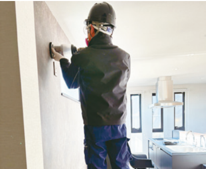
粉塵飛散防止カバーを使用した工事の様子
