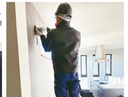
粉塵飛散防止カバーを使用した工事の様子
